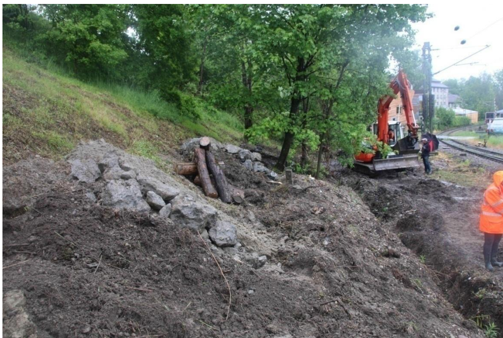
Abb. 1: Bau von Zauneidechsenhabitaten an Bahnböschungen (Projektbeispiel aus Südbayern)
