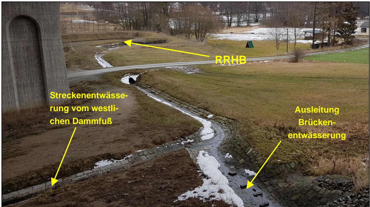
Abbildung 4: Zuflüsse zum RRHB unter der Talbrücke Münchberg
