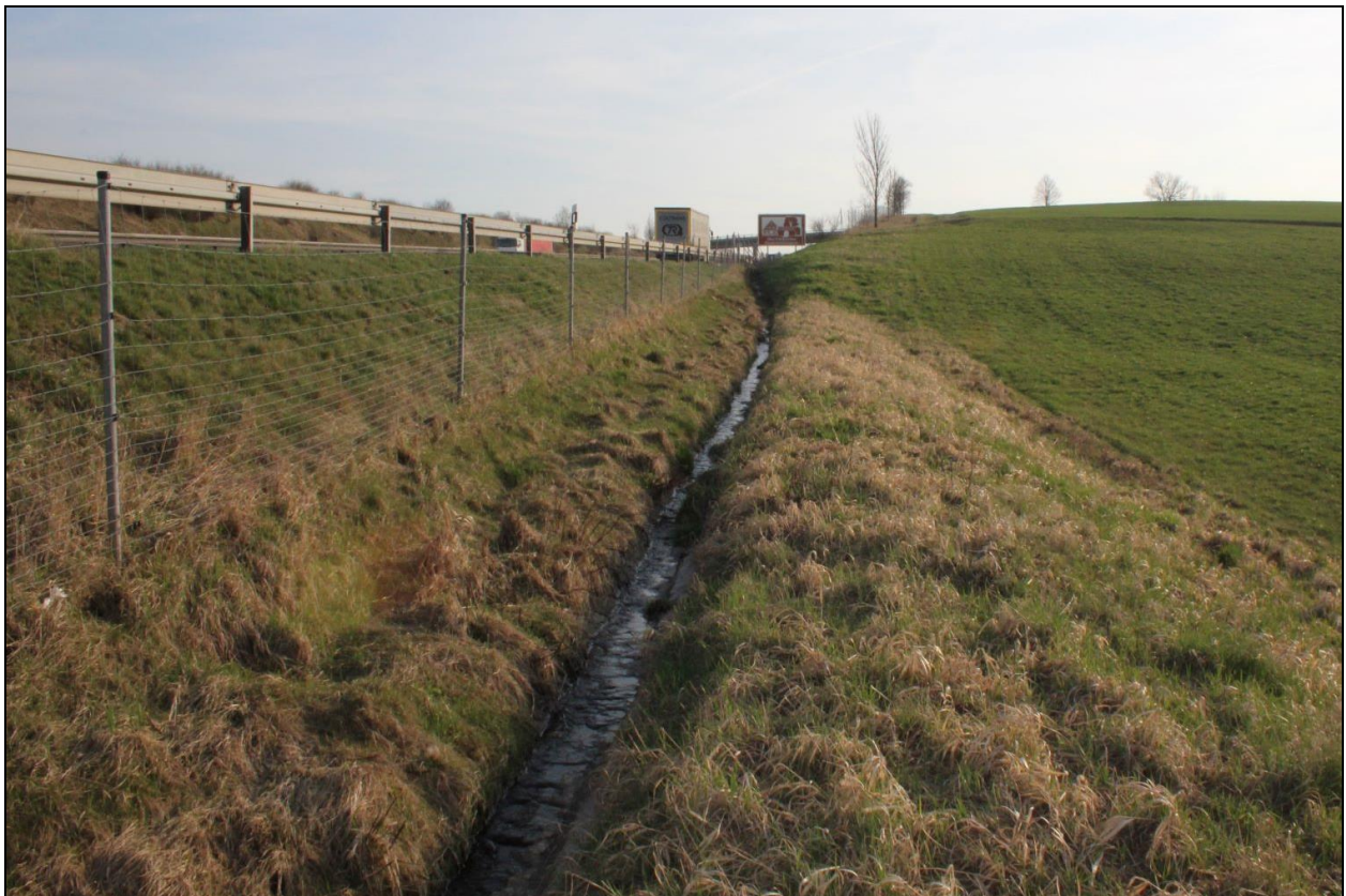
Abbildung 1: befestigte Mulde am Dammfuß der westlichen Richtungsfahrbahn der A 9 mit Übergang zur Einschnittmulde, Blickrichtung Süden
