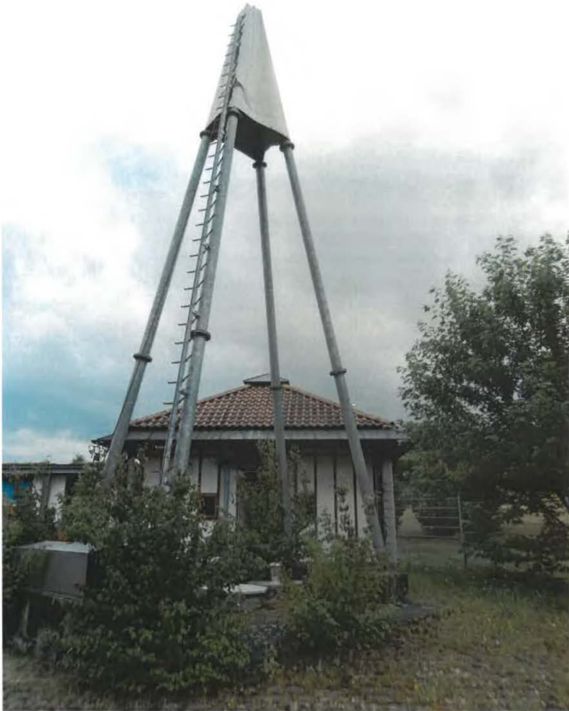
Abbildung 2: Brunnenhaus der Therme 2
