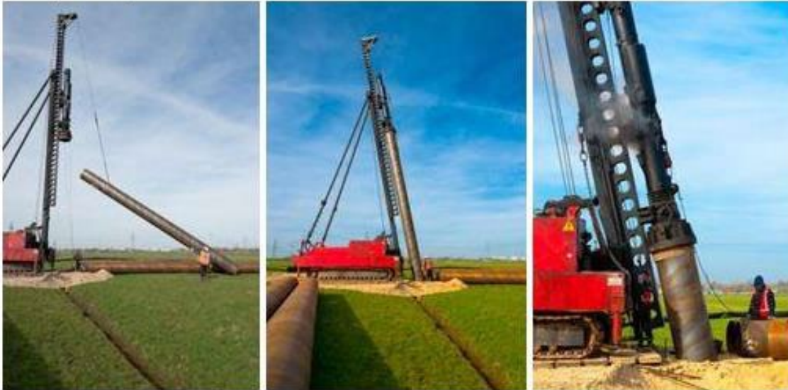
Abbildung 17 Abbildung 27 : Pfahlgründung
