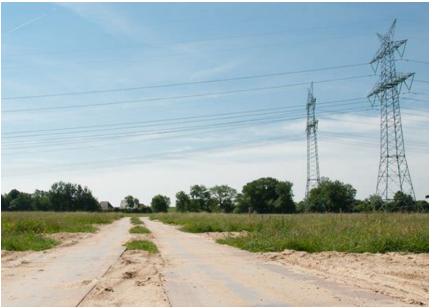
Abbildung 15 Abbildung 25 : Beispiel für eine temporäre Mastzufahrt
