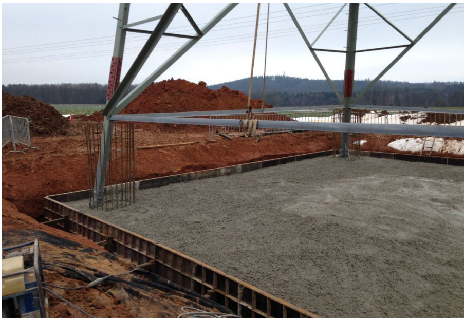
Abbildung 18 Abbildung 28 : Plattenfundament
