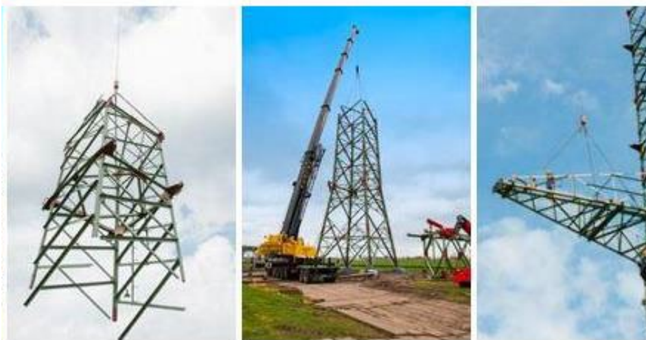
Abbildung 19 Abbildung 29 : Mastmontage mittels Mobilkran
