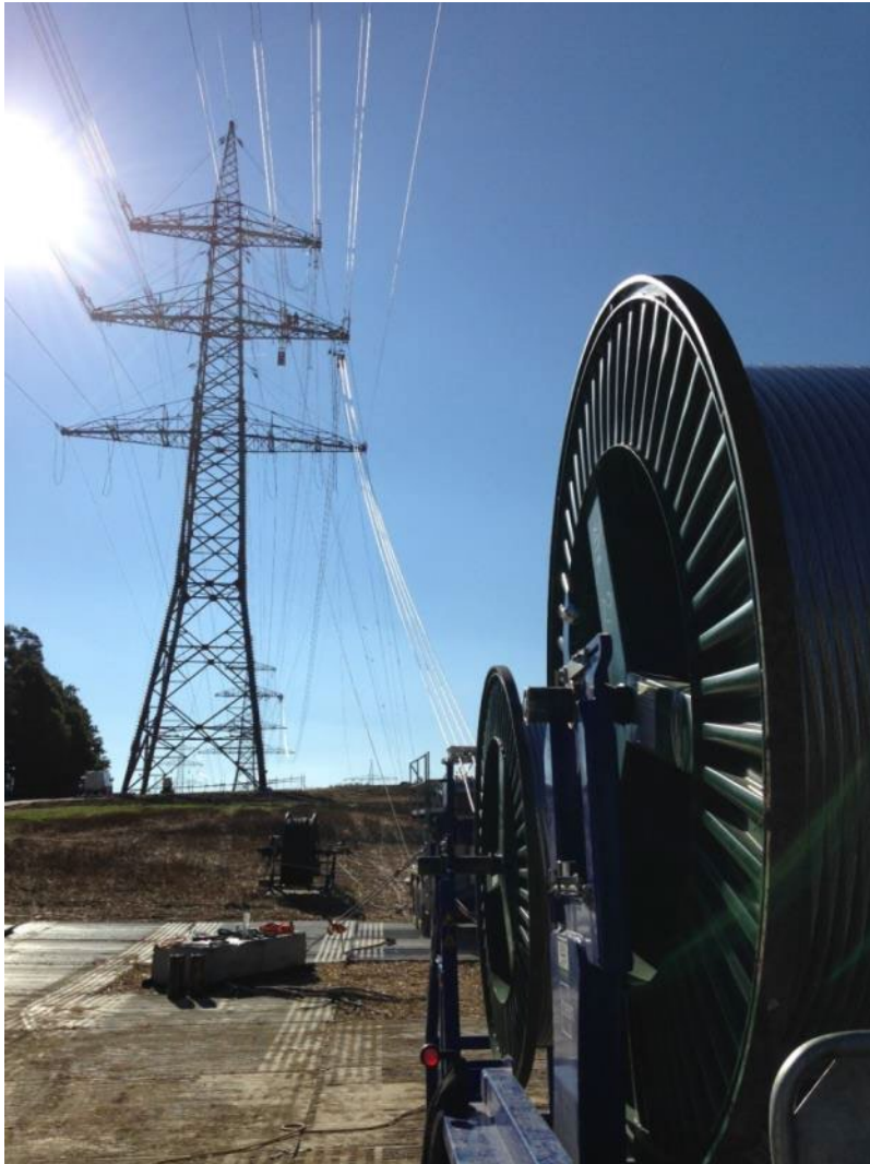
Abbildung 20 Abbildung 30 : Seilzug
