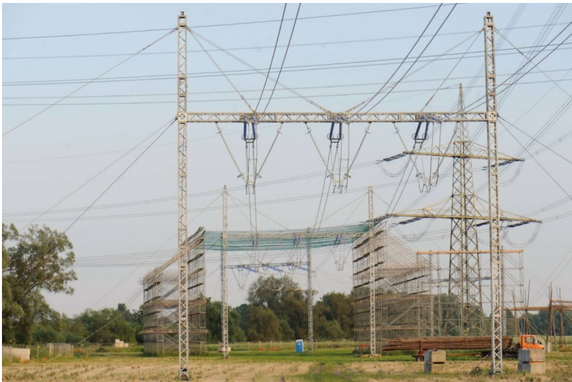
Abbildung 13 Abbildung 23: 380-kV-Freileitungsprovisorium für ein System mit errichtetem Schutzgerüst
