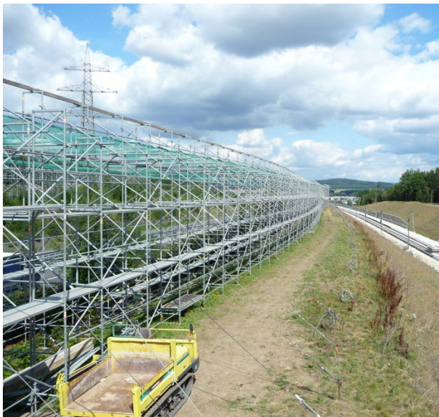
Abbildung 21 Abbildung 31 : Schutzgerüst aus Metall und Schleifgerüst aus Holz
