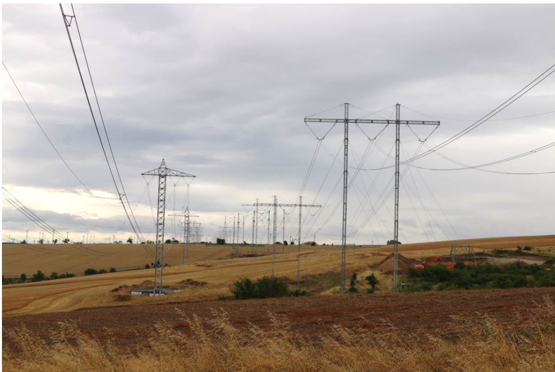
Abbildung 12 Abbildung 22 : 380-kV-Freileitungsprovisorium für zwei 380-kV-Stromkreise
