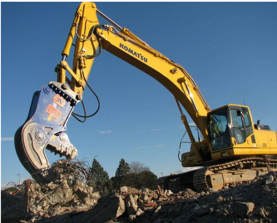
Abbildung 2.2: Bagger mit Abbruchzange (Pulverisierer)
