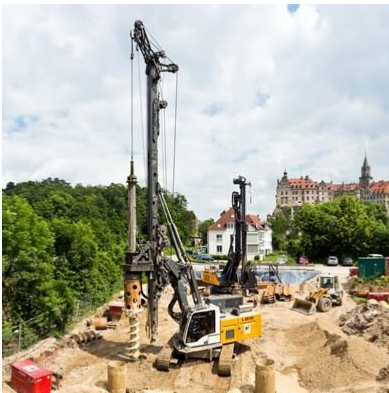
Abbildung 2.4: Bohrgerät zur Pfahlgründung der Masten
