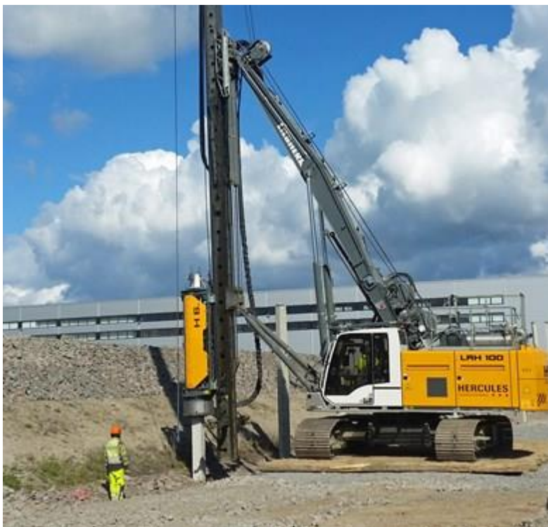
Abbildung 2.3: Rammgerät zur Pfahlgründung der Masten
