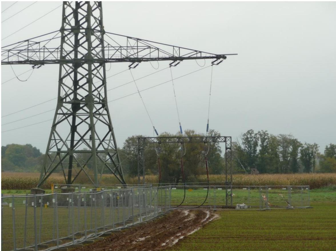
Abbildung 18: 110-kV-Kabelprovisorium mit Übergangportal
