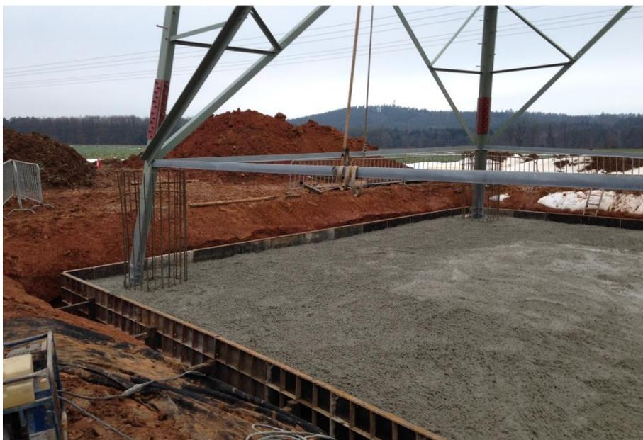
Abbildung 22: Plattenfundament
