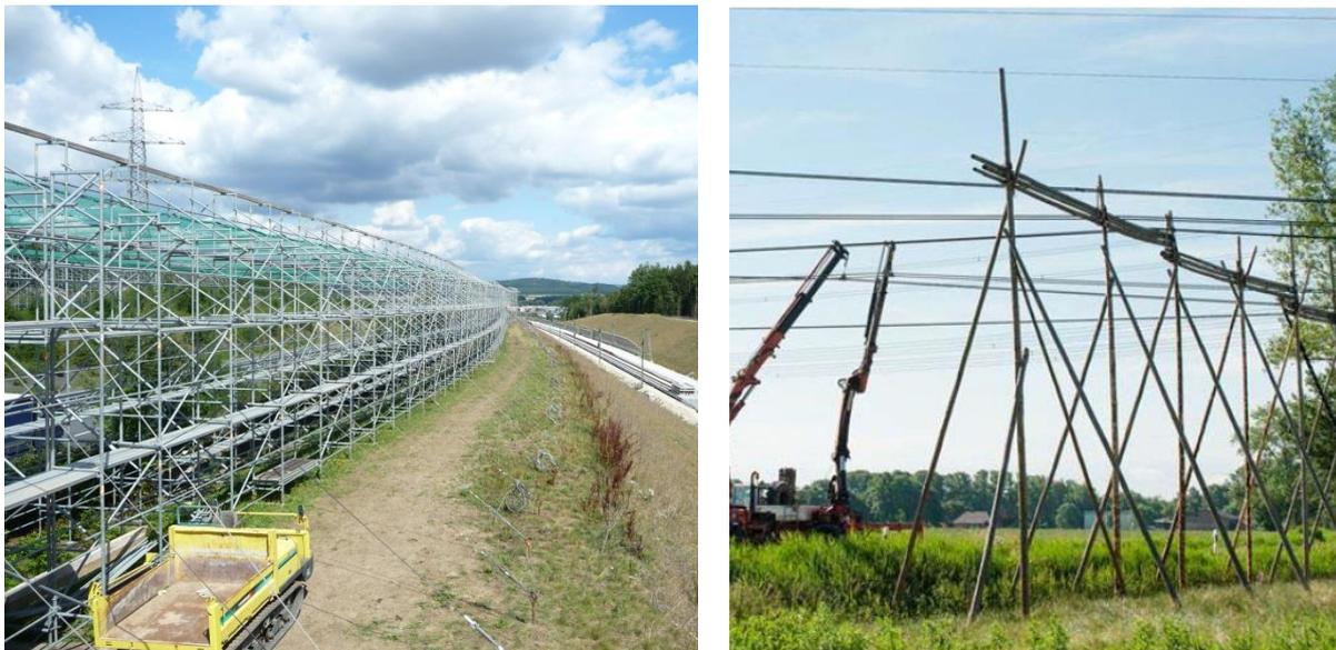
Abbildung 25: Schutzgerüst aus Metall und Schleifergerüst aus Holz
