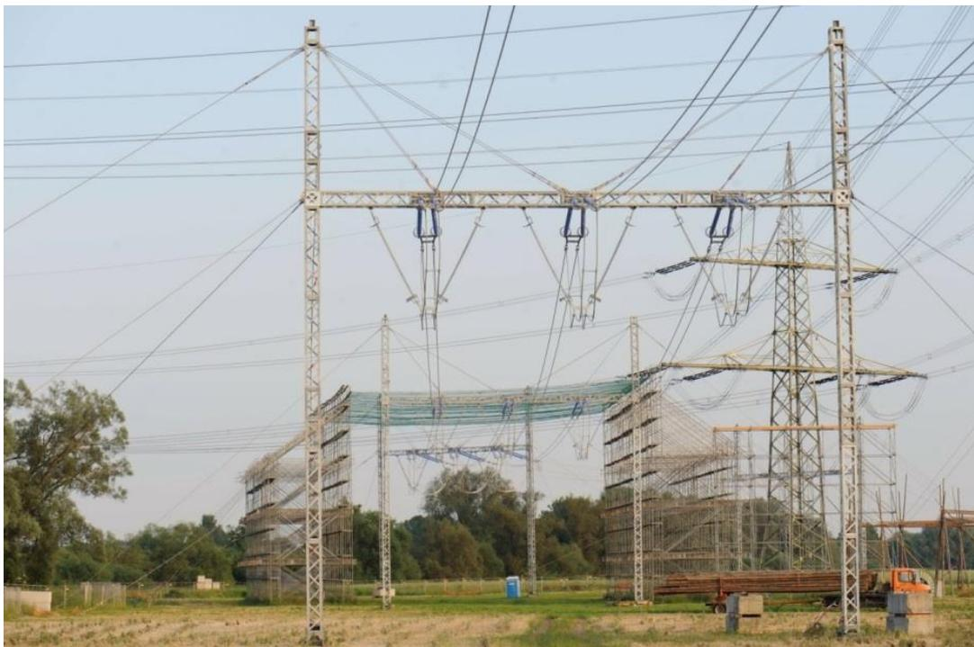
Abbildung 17: 380-kV-Freileitungsprovisorium für ein System mit errichtetem Schutzgerüst
