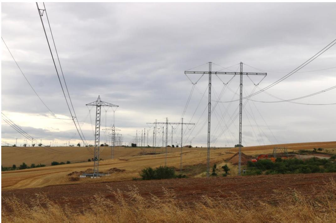
Abbildung 16: 380-kV-Freileitungsprovisorium für zwei 380-kV-Stromkreise
