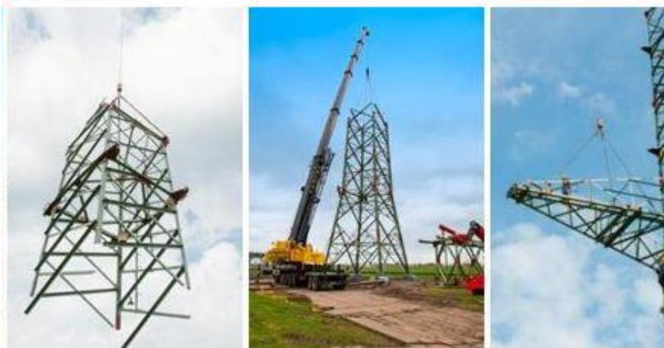
Abbildung 23: Mastmontage mittels Mobilkran
